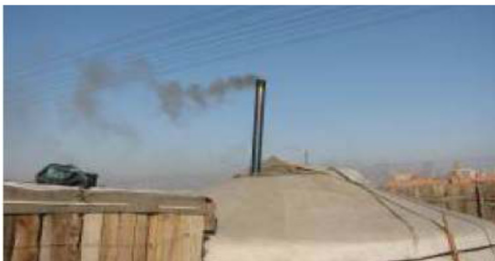
〈그림 2-6〉 게르의 연기배출 파이프 및 오염물질 배출 상태
