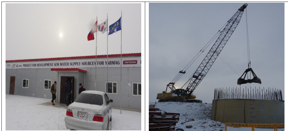
<사진 4-2. 몽골 물랜드마크 사업 공사현장>
