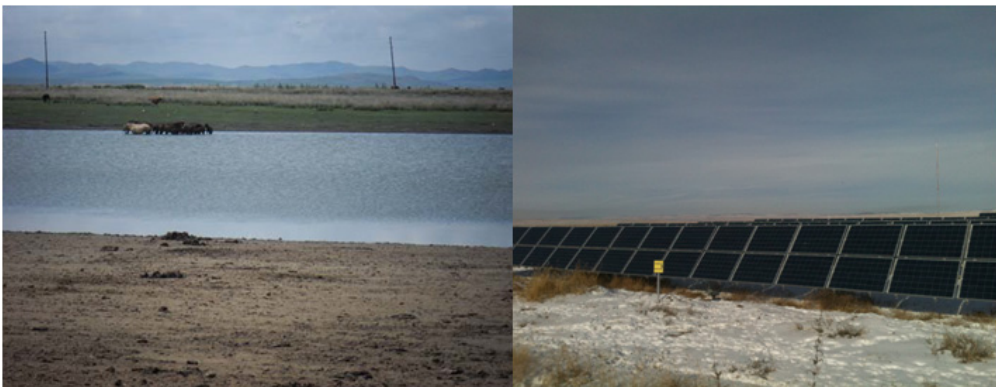
<사진 4-8. 바얀누르 군 호수 및 태양광 패널 전경>
